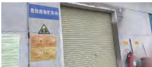
危险废物暂存间
